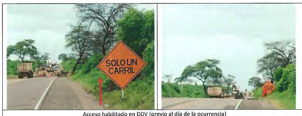
Acceso habilitado en DDV (previo al día de la ocurrencia)
