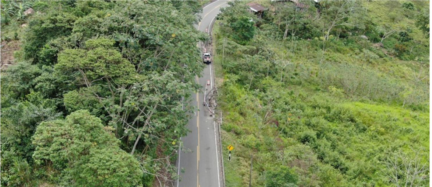
En ambos casos hay un desplazamiento puntual hacia el talud inferior. Esto se debe a un problema geotécnico en el lugar, que además se encuentra en una zona lluviosa, lo que contribuye a hacerlo inestable. La afectación que se produce dentro de la plataforma hace que el sector sea calificado como de "alto riesgo". Dentro del Contrato de Concesión, esta situación implica la necesidad de una obra accesoria.
