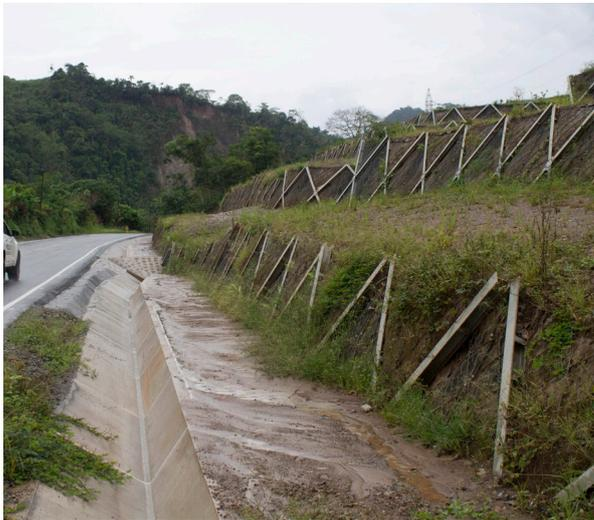
Esta es una de las principales soluciones de ingeniería que se utiliza para la contención y estabilización de taludes. Con su aplicación se disminuyen los riesgos de derrumbes a lo largo de la carretera.
