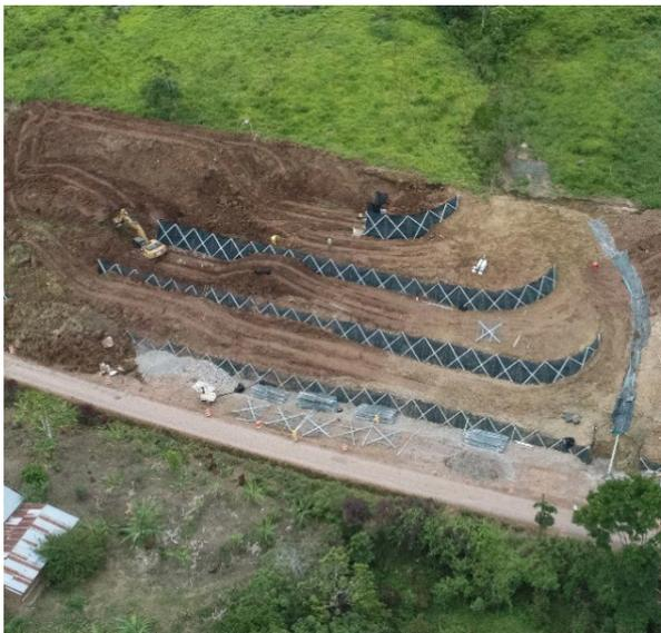
El sistema Erdox tiene la ventaja de ser una solución de tipo permanente, por lo que, una vez instalado, se evita cualquier riesgo de derrumbe. Además, no requiere de un mantenimiento o monitoreo específico y puede ser utilizado en todo tipo de terreno, por lo que puede ser colocado en costa, sierra o selva.
