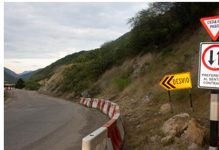
De acuerdo con el informe Inspección de Seguridad Vial para los 35 Sectores con Requerimientos de Obras Accesorias, el lugar está catalogado como "de alto riesgo" porque, además de lo mencionado, existe la posibilidad de reactivación de masas del talud desplazado, especialmente en época de lluvias.
