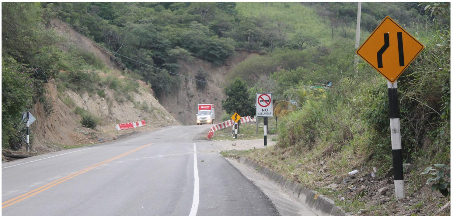
Para prevenir accidentes, IIRSA Norte ha implementado las siguientes medidas de seguridad adicionales: señalización vertical adicional con indicaciones de velocidad, señalización de peligro, pictogramas de curva y barreras de seguridad con cinta reflectiva.
