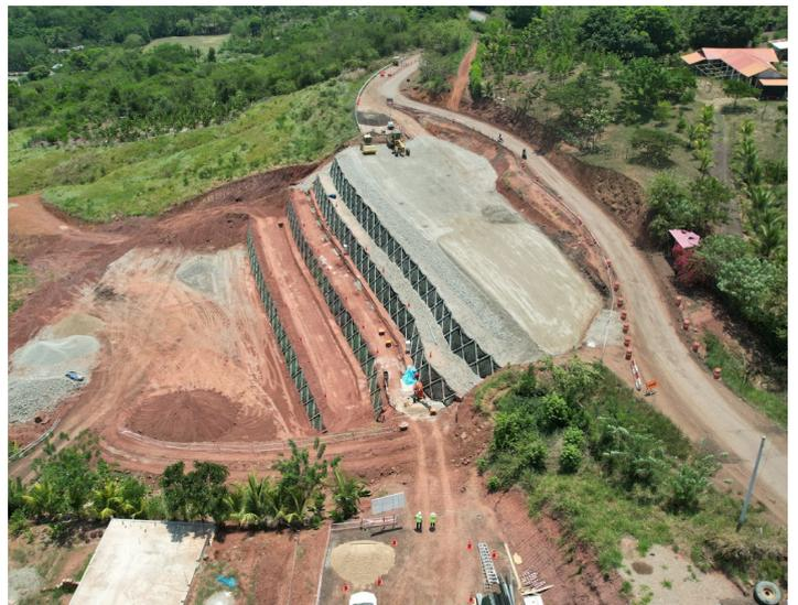
La propuesta fue aceptada y actualmente estamos ejecutando la estabilización del talud inferior con el sistema Erdox, para posteriormente restituir la plataforma y el asfalto en el lugar. Este es un trabajo que nos permitirá brindar mayor seguridad a los usuarios que diariamente transitan por la vía, mientras se da la aprobación de una solución definitiva para el problema que afecta al lugar.
