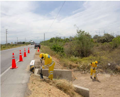
Mantenimiento rutinario de alcanzarillas Tramo 7
