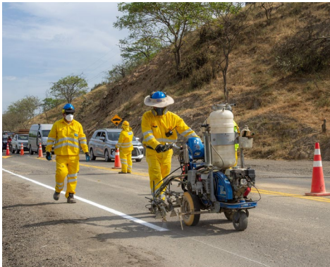
Trabajos de señalización horizontal sector Tongorrape
