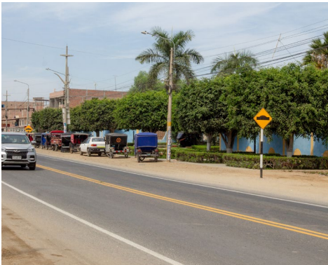
Trabajos de mantenimiento Ilimo
